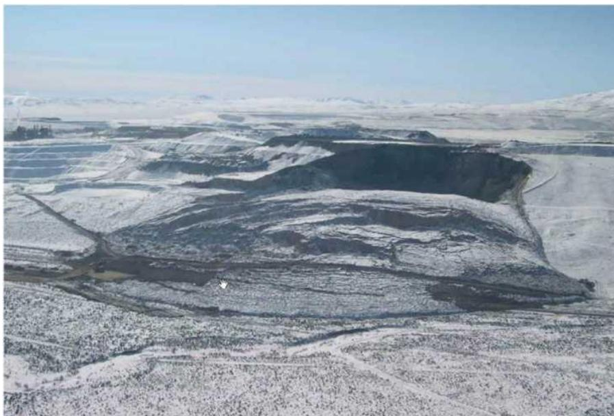
Рисунок А27 – Деформация породного отвала карьера
