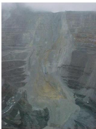
Рисунок А24 – Фильтрационная деформация на полиметаллическом карьере
