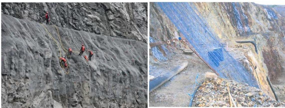
Рисунок 4.21 – Защита откосов от камнепада металлическими сетками
