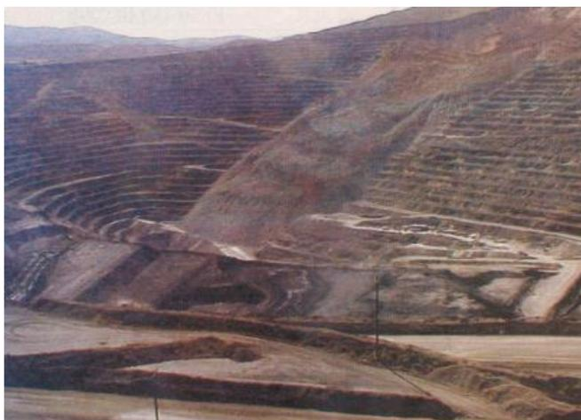
Рисунок А29 – Деформация при сейсмическом воздействии землетрясения на карьере
