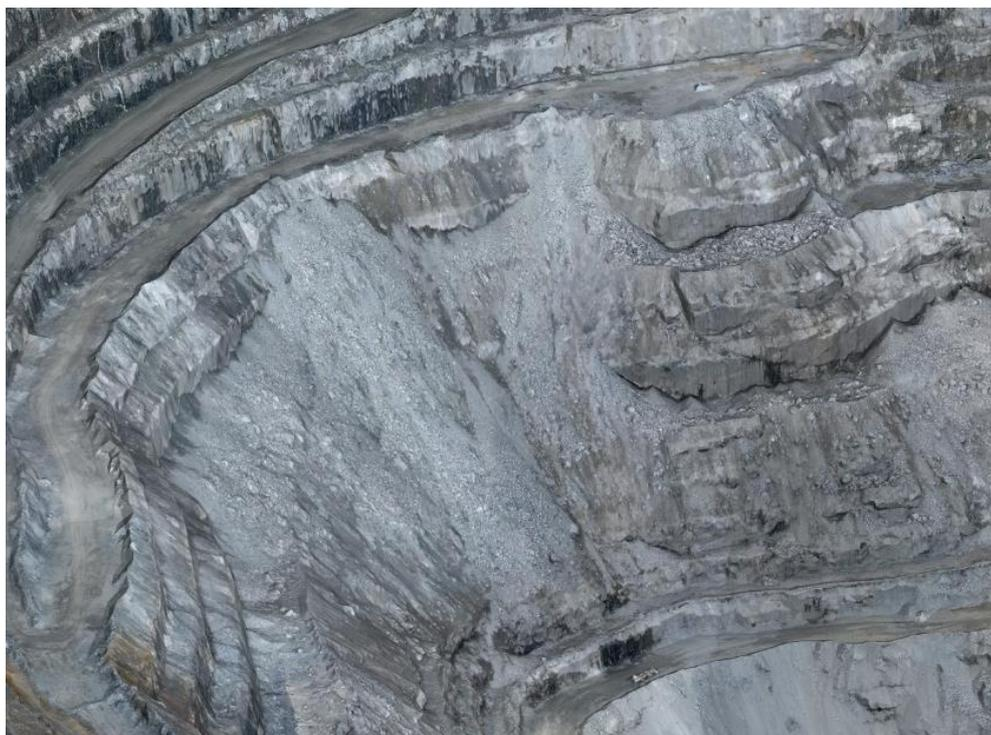
Рисунок А1 – Участок осыпания и камнепада на Ковдорском месторождении магнетит-апатитовых руд
