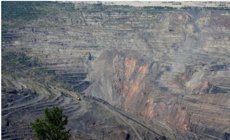
Рисунок А18 – Оползень на угольном разрезе
