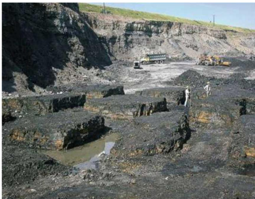
Рисунок А23 – Обрушение дна карьера из-за заброшенных подземных выработок
