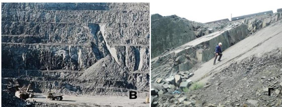
Рисунок А8 – Пример фактических макродеформаций: а, в - клиновидные деформация; б – деформация опрокидывания, г – плоская деформация
