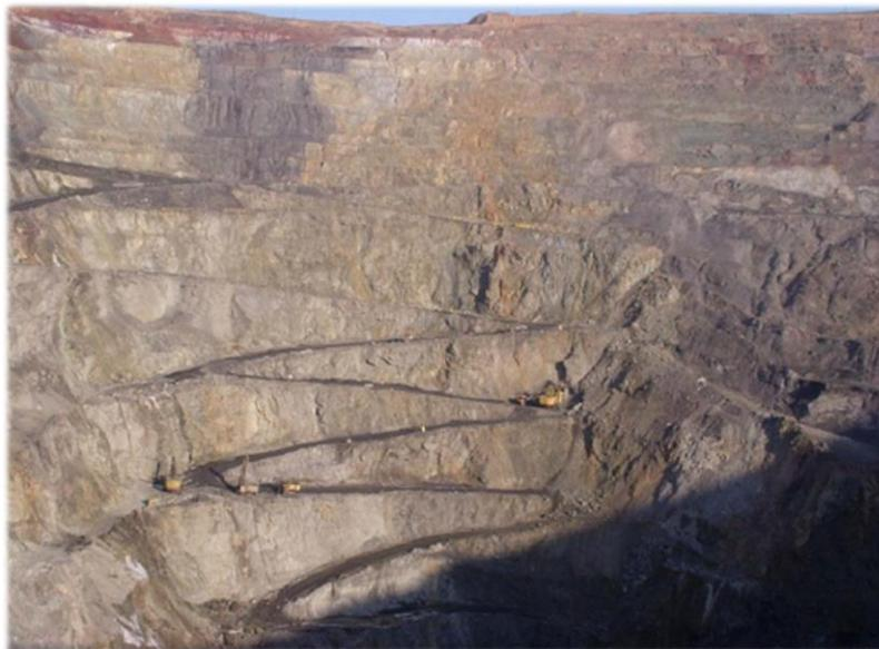
Рисунок А21 – Пример оползня, связанного с подземной подработкой на карьере полиметаллического месторождения
