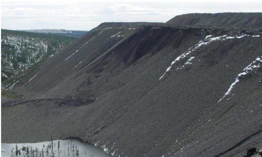
Рисунок А26 – Оползень на отвале угольного разреза
