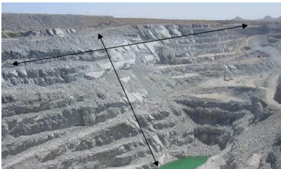
Рисунок А4 – Деформации уступов на карьере
